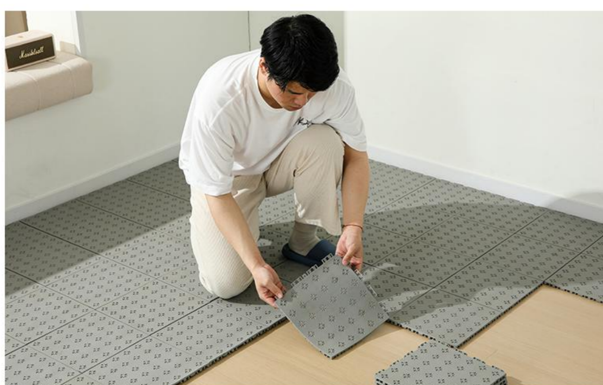
悬浮块拼装铺设 (约 30分钟)
