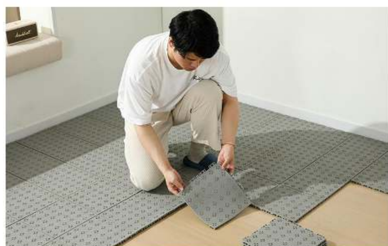
悬浮块拼装铺设 (约 30分钟)
